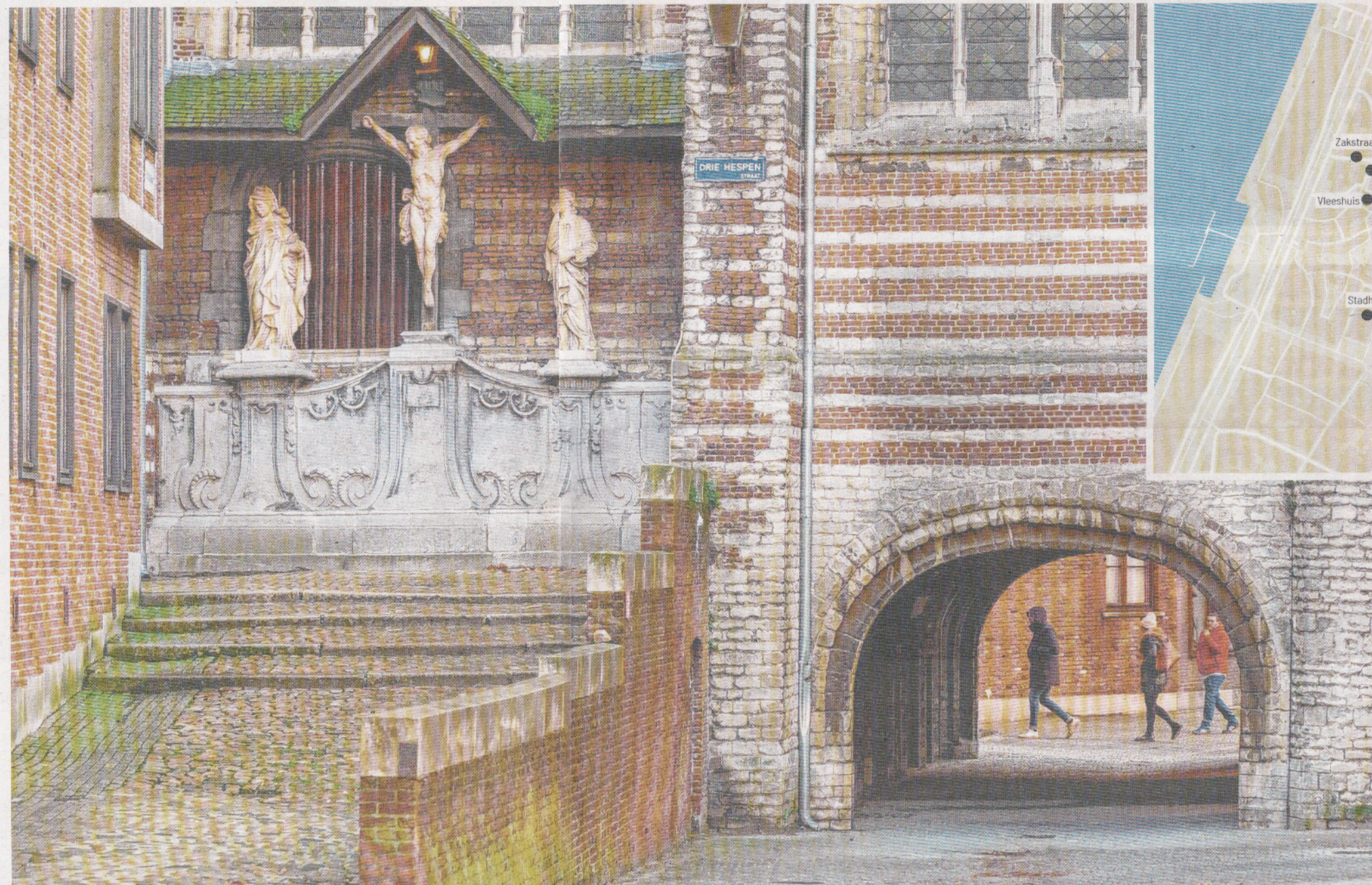
Het Vleeshuis wordt vanaf 2025 gerenoveerd. Een van de oudste gebouwen van de stad heeft dringende herstellingen nodig. FOTO JORIS HERREGODS
